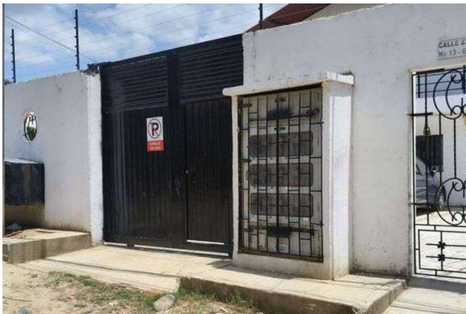
Este es el conjunto residencial que no recibe agua potable, como debería.
